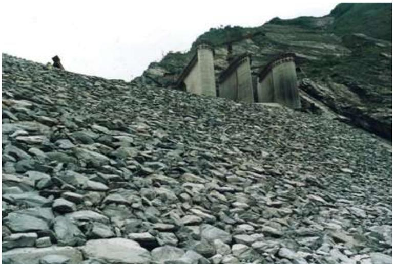
di deviazione e cofferdam (o ataguia), il rilevato della diga è già su di quota. I materiali impiegati per la realizzazione dello sbarramento sono per la maggior parte argilla e arenisca; materiali sabbiosi e ghiaiosi per i filtri; pietrame di piccola e media pezzatura per le scarpate di valle e di monte.
