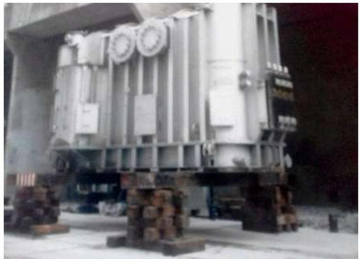
FOTO 2 - Uno de los 12 transformadores de potencia taqueado; a la espera de colocarle los boguis de 100 tn c/u para carretearlos al fondo de la playa donde estaba instalado el malakate anclado al hormigón para empezar a hacerle los ensayos de humedad mediante las baterías de Hidrógeno que transporta cada o sea dos juegos de baterías 4 y4 para evitar cualquier inconveniente durante su traslado en barco.
